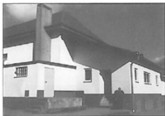
Anbau der Umkleide- und Duschräume auf der Rückseite der Halle 1987/89
