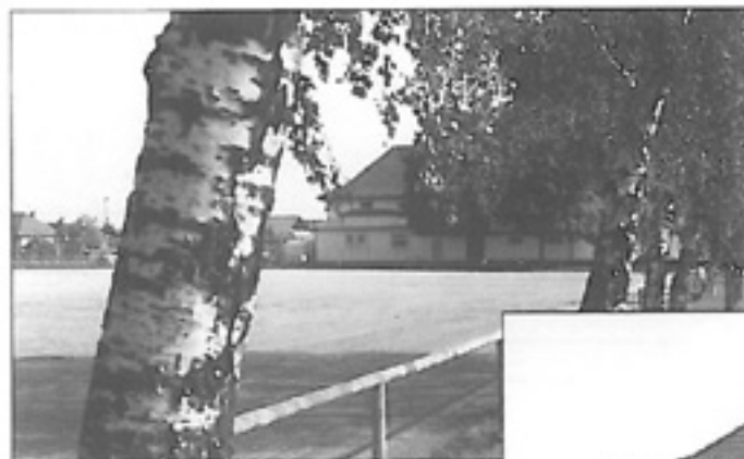
Die renovierte TuRa-Halle 1993
